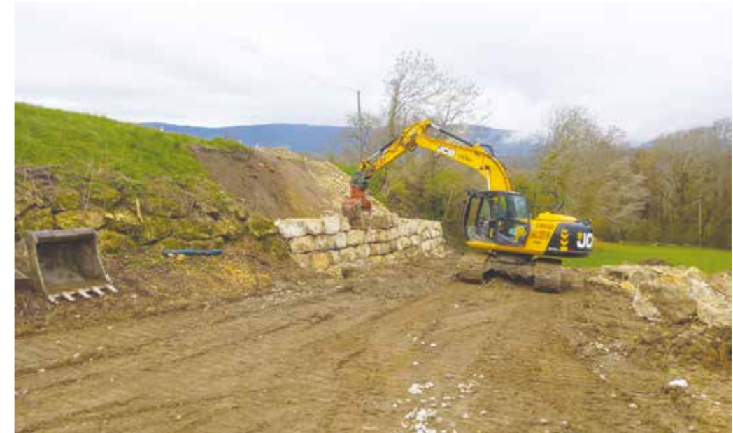
Travaux de consolidation de la route du Vernay
